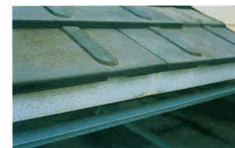
実物件屋根材の 暴露観察材 (約20年) ラスコールN #100
