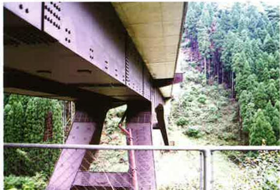
箱桁橋梁塔 (7年後)
