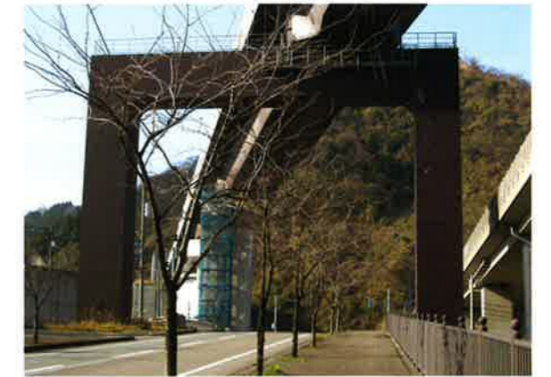
橋脚および桁 (日本海より数km) (約10年後)
